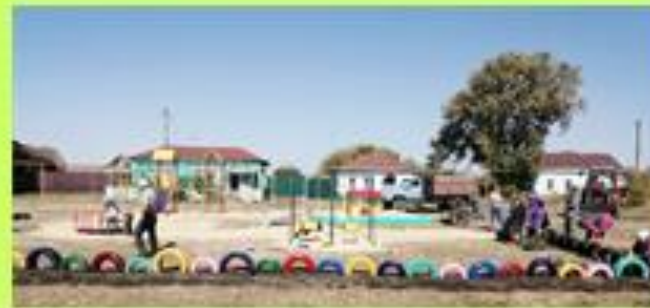
ТОС «Александровское» Строительство детской площадки
