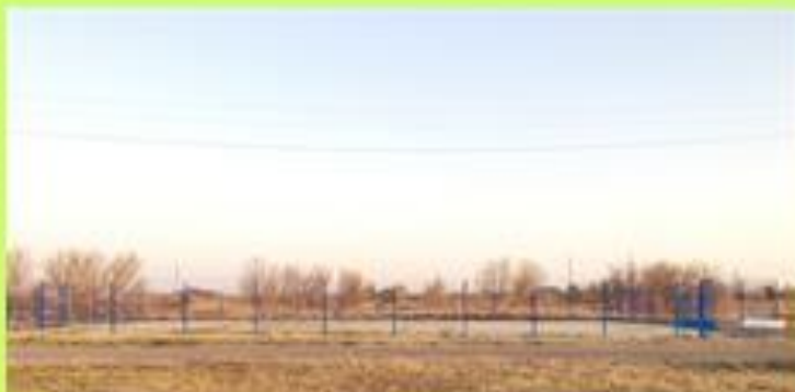
ТОС «Васильевское» Строительство футбольной площадки
