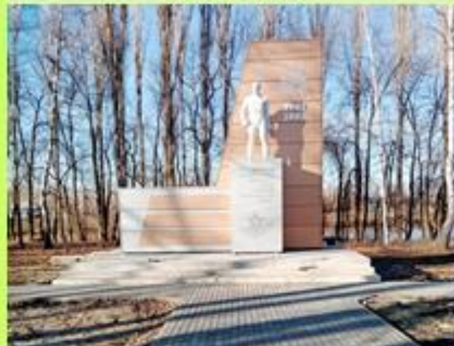
ТОС «Казанское» Ремонт памятника
