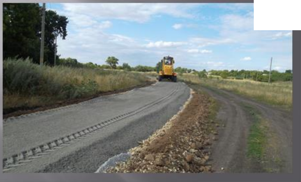
Отсыпка щебнем дороги в п.Участок №12
