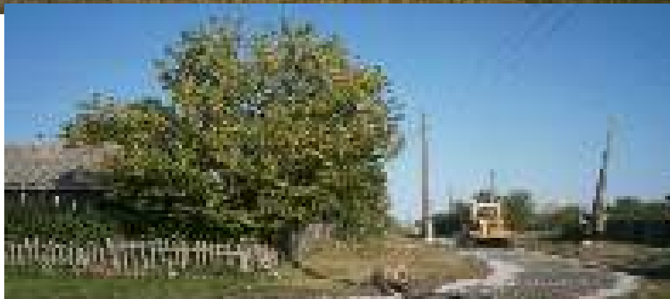
ТОС Зареченский. Отсыпка щебнем дороги по ул. Есенина п. Зареченский
