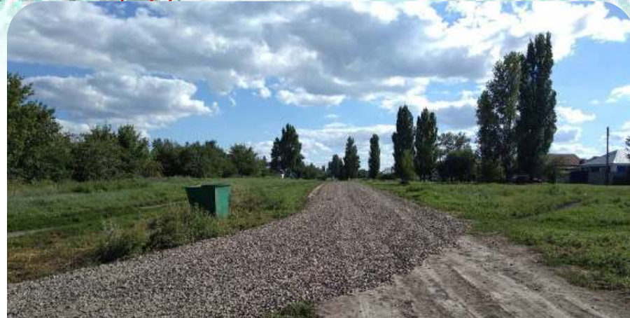
ТОС «Высоковское» отсыпка дороги щебнем.
