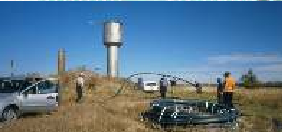
ТОС «Коминтерновское» замена водопроводной трубы
