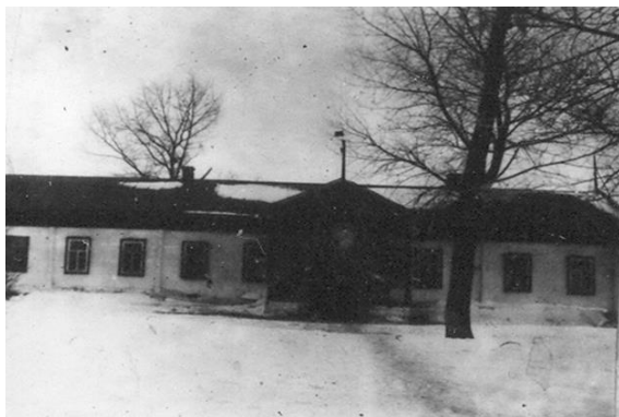
Дом помещика Мамонтова. Старое здание школы
